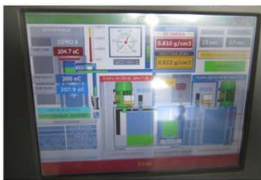
Slika 19: Nadzorni panel sistema za nadzor gostote fluksa
